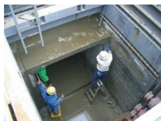
▲函体縦締用PC鋼棒緊結状況
