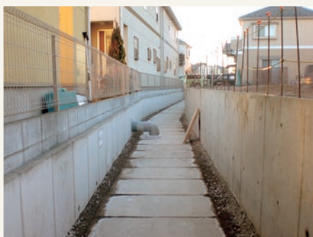
▲施工後（急曲線部R=17m）
