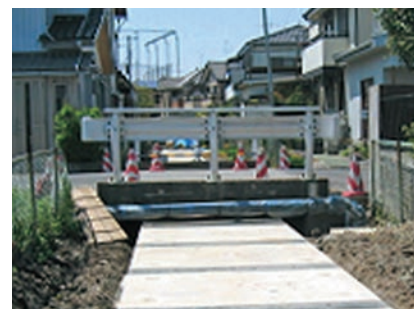
▲既設橋梁下横断
