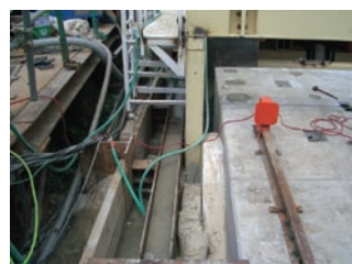
▲裏込注入状況
