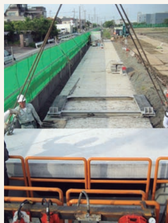
▲施工状況（函体据付け）
