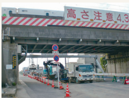
▲施工全景（JR高架下施工状況）
