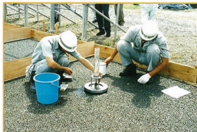
現場透水試験の状況
