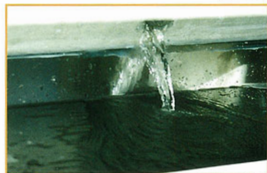
散水の排出状況
