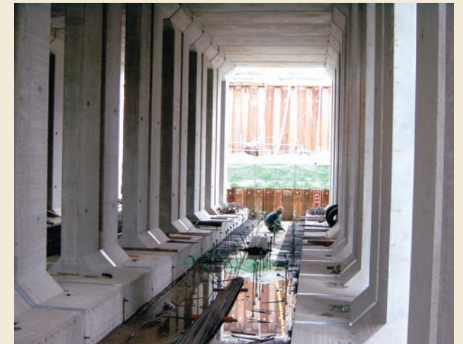
3 プレキャストブロックの据付完了
