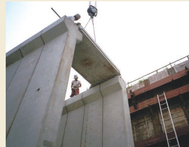
2 スラブの据付
