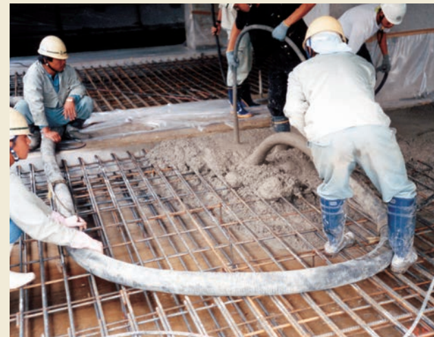
5 底版部コンクリート打設
