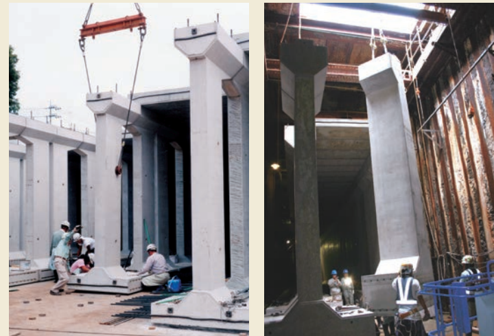
スタンド型タイプ ブロックの据付
