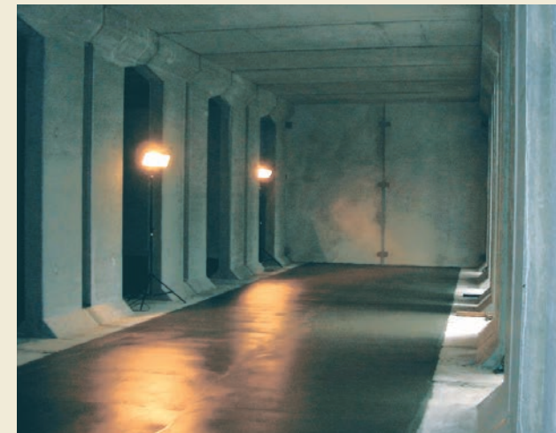
6 コンクリート打設完了
