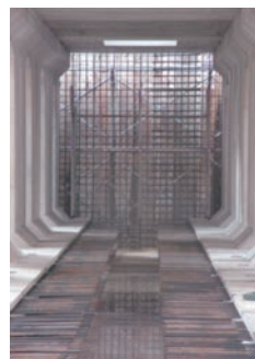
●現場打ち端壁
