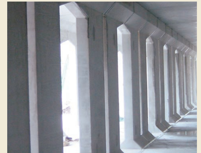
7 完成した遊水池の内部
