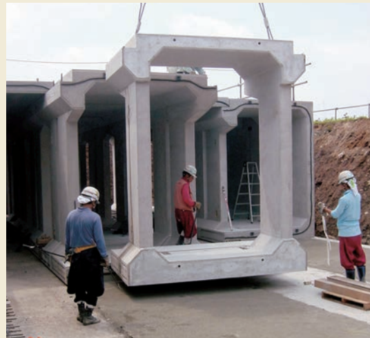
1 ボックス型タイプ ブロックの据付
