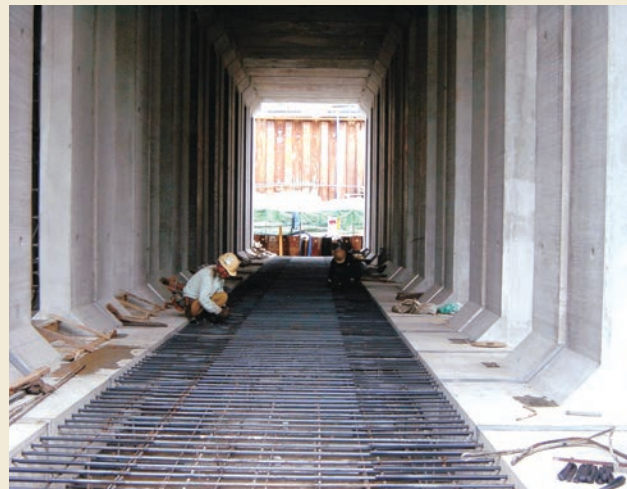
4 底版現場打ち部の配筋
