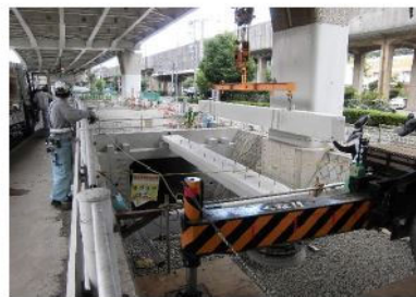
水路の暗渠化工事 梁
