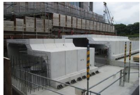
配管ビット・カバー
