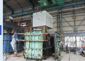
一定の養生が施された後、 型枠から製品を取り出します。
