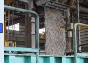
型枠にコンクリートを投入します。
