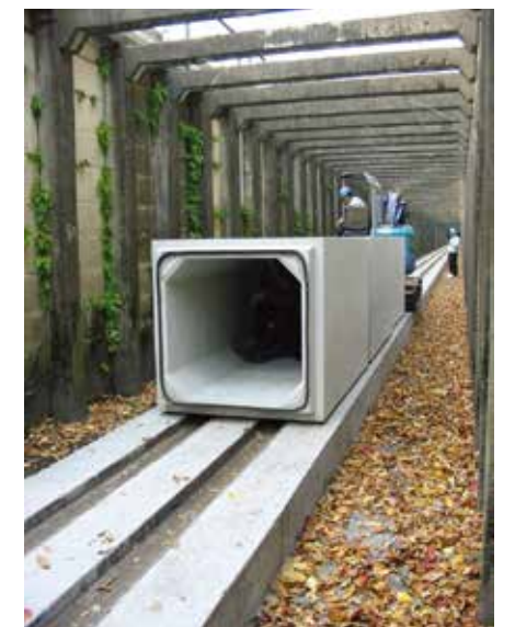
クレーン車が使用できない狭い場所での施工
