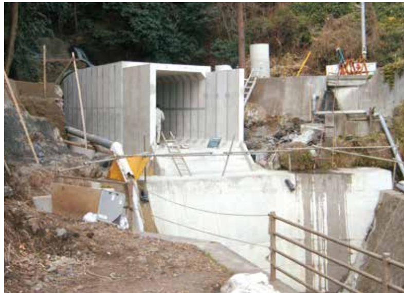
ボックスカルバート水路
