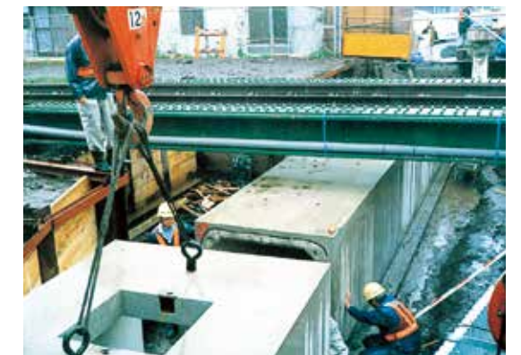
軌道下での施工
