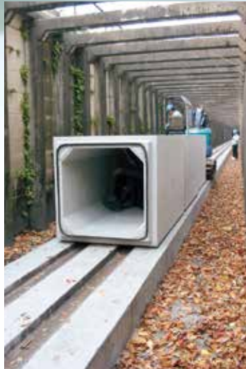
ボックスカルバート ローラースライド工法
