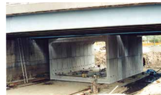
橋梁下での施工
