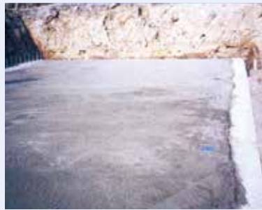
敷きモルタル2cm布設
