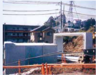
ラフタークレーン(25~50t)車で 各ブロックをセット
