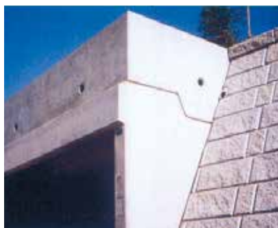
シャッターBOX上から築造した擁壁
