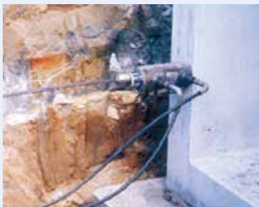
緊張ジャッキにて緊結 グラウト作業
