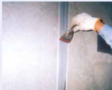
ブロック間の目地を内側から 防水ウレタン材でシーリング
