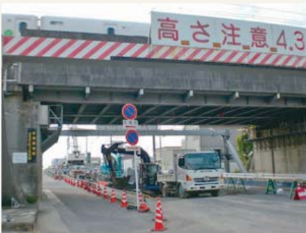
▲施工全景 (JR高架下施工状況)
