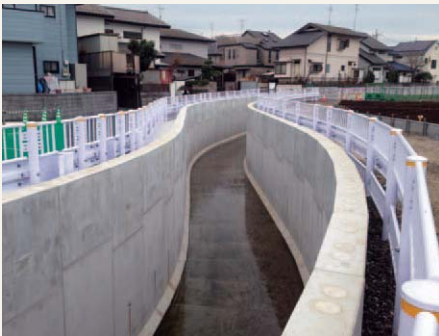
▲施工後（急曲線部 R=20m、30m）
