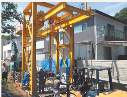
▲施工状況（函体運搬・据付け）
