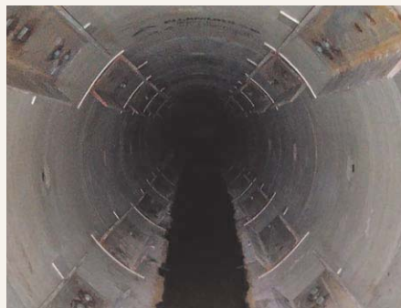
▲敷設推進管内
