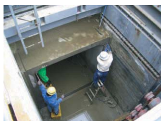
▲函体縦締り用PC鋼棒緊結状況
