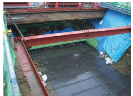
▲FCプレート設置状況
