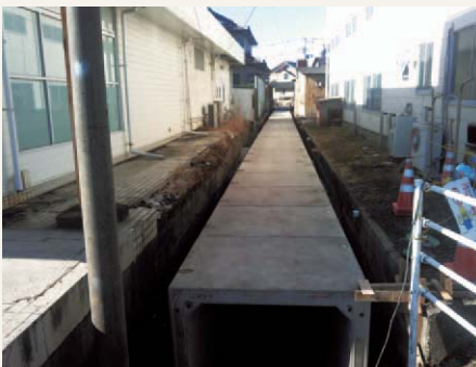
▲施工後 (函体敷設完了)
