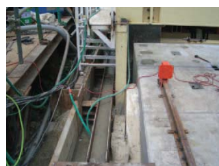
▲裏込注入状況
