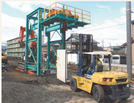
▲施工状況 (函体運搬・据付)
