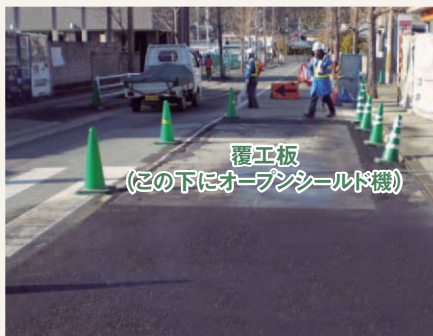
▲シールド機上を覆工し、夜間交通開放
