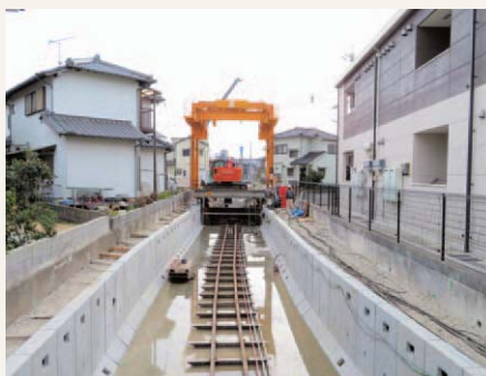
▲施工状況 (敷設済みU型開渠)
