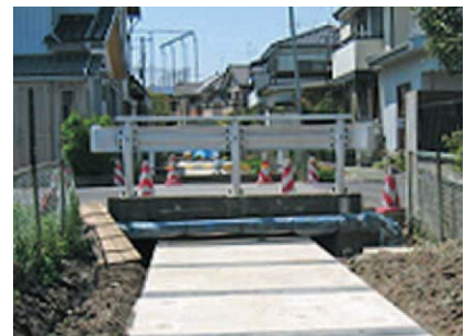
▲既設橋梁下横断
